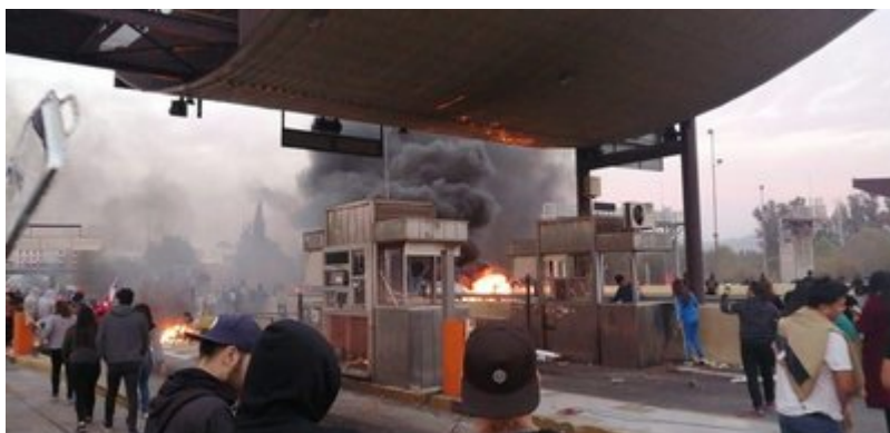
Péage de la Route 78 dans la comuna de Peñaflores, détruit le 19 octobre 2019. Cc Wikipedia
