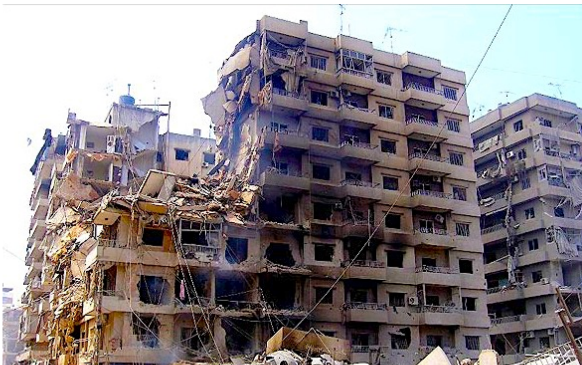
Attaques aériennes et d'artillerie israéliennes contre un immeuble d'habitation, Beyrouth 2006. (Hamed Talebi/Mehr News Agency/Wikimedia Commons)
